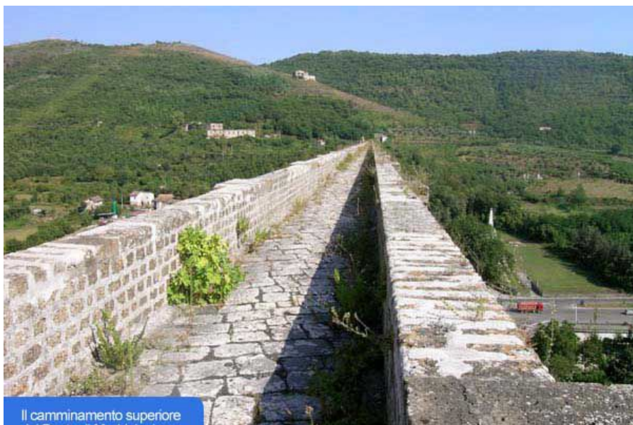
parapetto e lastricato del Ponte di Maddaloni
