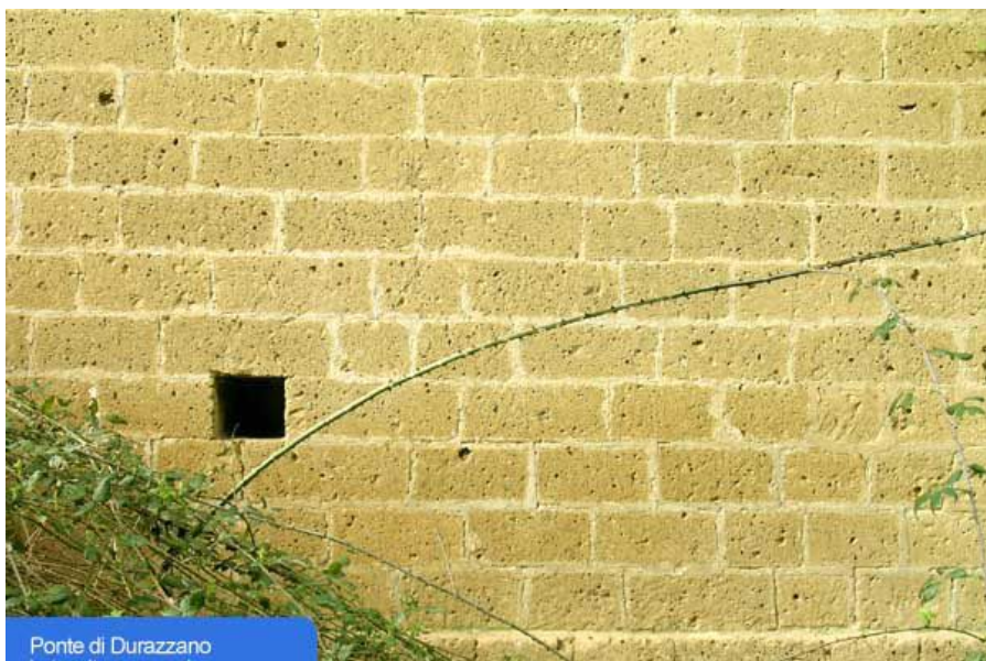
Ponte di Durazzano basamento dei pilastri
