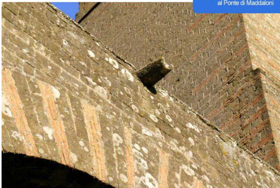
particolare del gocciolatoio al Ponte di Maddaloni
